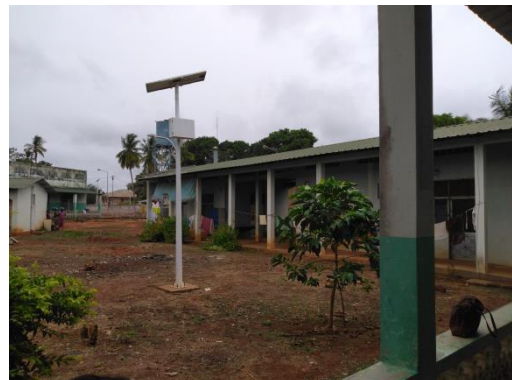
Fotografia 12 Interior do hospital
