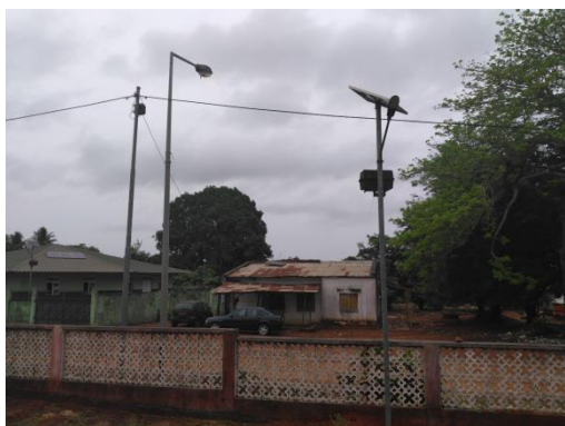
Fotografia 13 Vizinhança do local da incineradora
