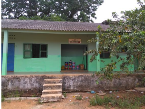
Fotografia 1 Edifício principal do hospital de Bolama
