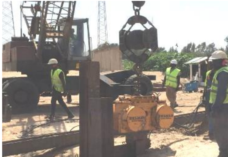
Fotografia 32 Sistema de escoramento por estacas-pranchas
