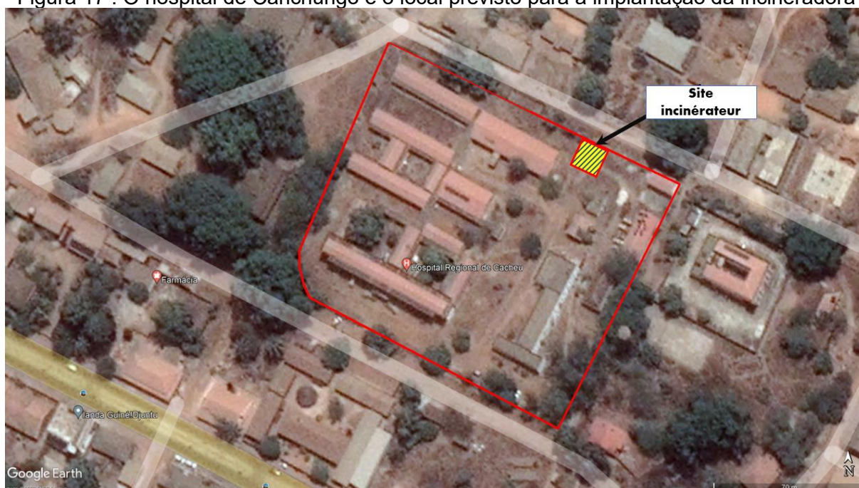
Figura 17 : O hospital de Canchungo e o local previsto para a implantação da incineradora
